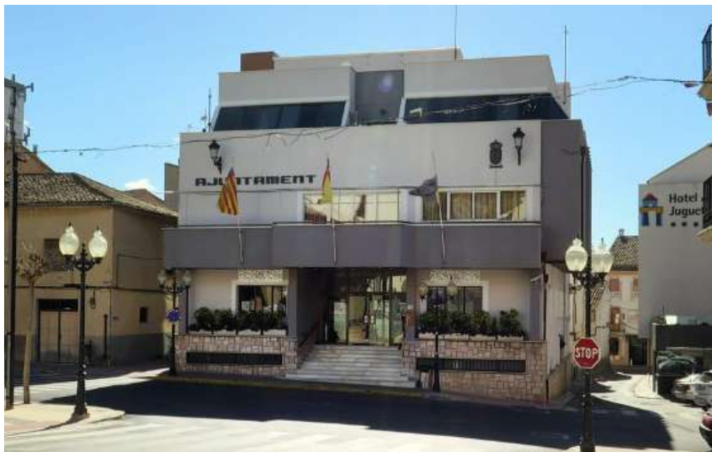
Ilustración 22: Edificio CECOPAL ayuntamiento del municipio de Ibi.
