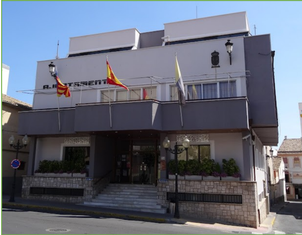
Ilustración 12: Edificio alternativo destinado a cumplir las funciones del CECOPAL, ayuntamiento de Ibi.
