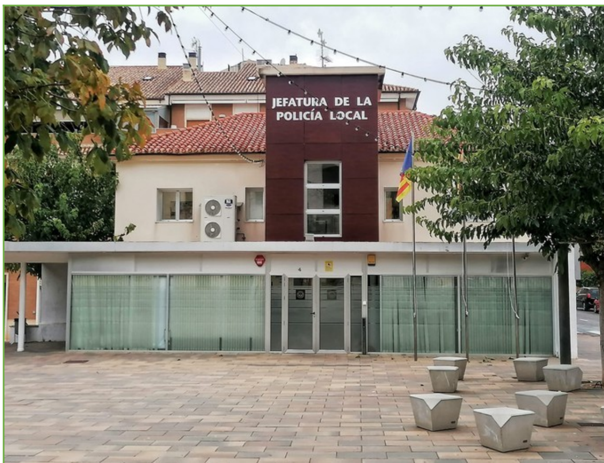
Ilustración 11: Edificio para albergar el CECOPAL, edificio de la Policía Local de Ibi.
